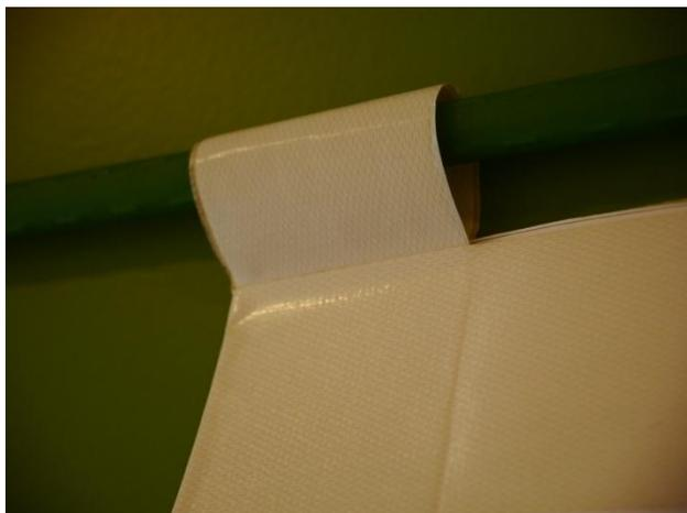
第3に、大型ユニットの上端に装着した5つのループに支柱となる園芸用ポール（スチール製。直径11mm×長さ182cm、重さ約125g）を通す。【図-4】
