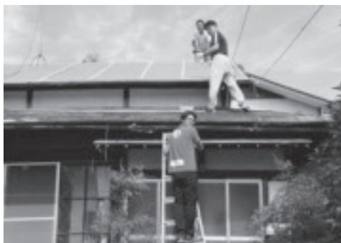
補修作業を行うボランティアのみなさん。
