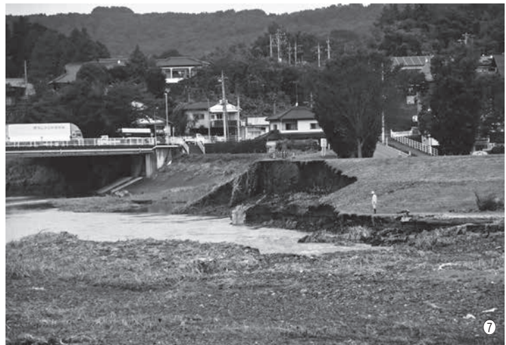
①浸水により剥がれたアスファルト(下境)、②自衛隊により中央公園に設置された野外風呂、③漂流物が絡まったブランコ(大桶運動公園)、④浸水により泥だらけになった南那須公民館事務室、⑤旧境小に運び込まれた大量の量、⑥増水した荒川(岩子)、⑦増水によりえぐられた堤防(岩子)、⑧各地で倒木が発生し道路が寸断された(下境)、⑨藤田地区の決壊した堤防
