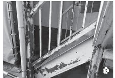
①雨漏りによりシミの付いた天井、②老朽化により屋上の段差にはヒビが、③塗装が剥がれサビた階段。
