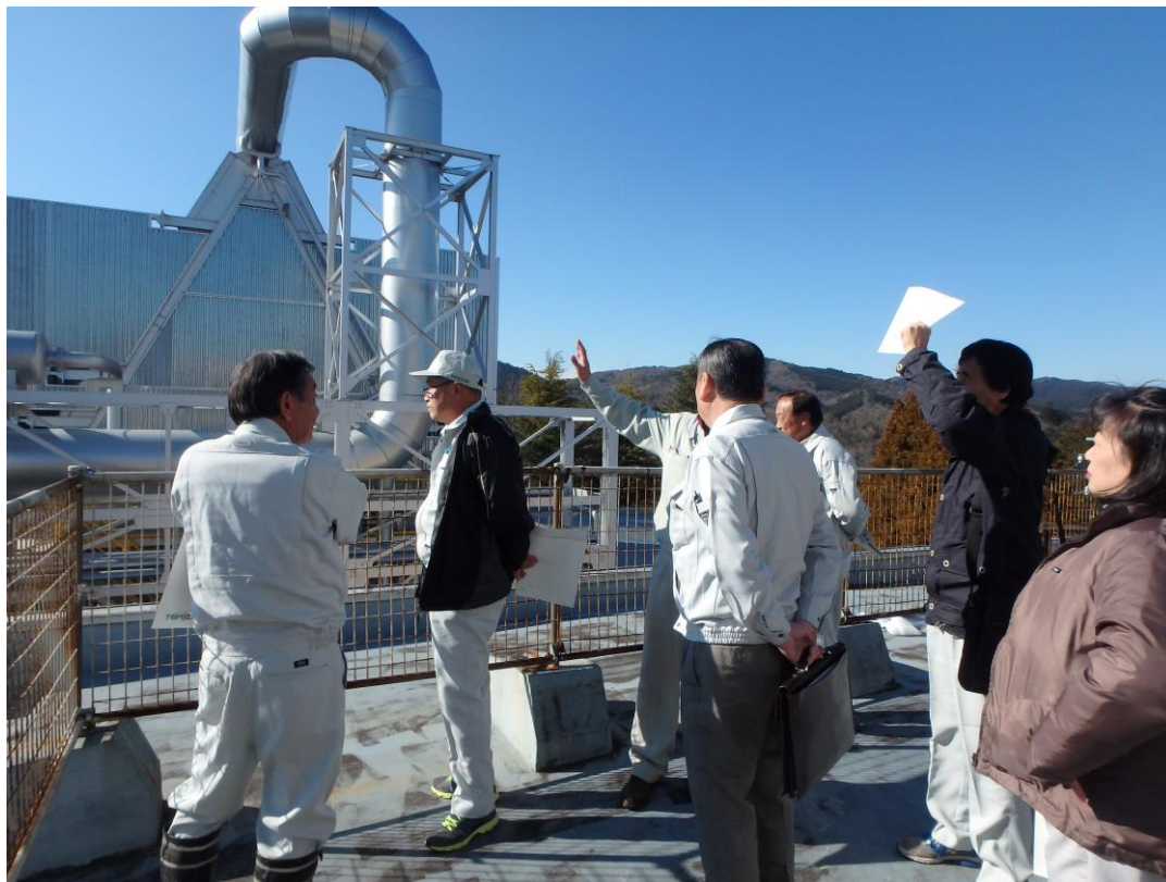
那珂川町のバイオマス燃焼発電所にて
