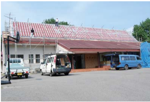
修繕が進む「わらび荘」
