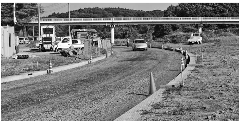
拡幅工事が進む市道鴻野山小倉線
