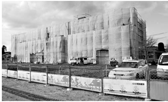
改修工事が進む旧野上小学校
