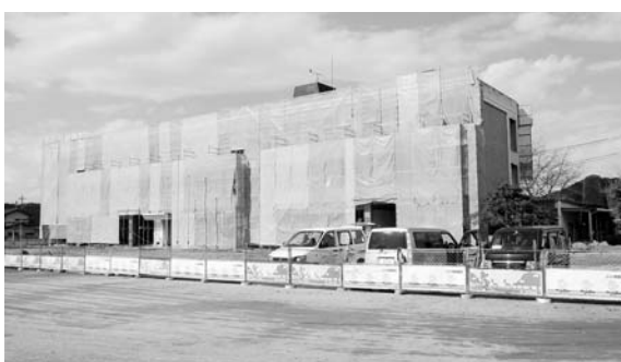
改修工事が進む旧野上小学校
