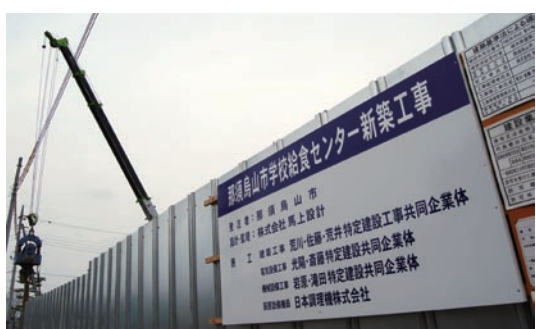
建設が始った給食センター
