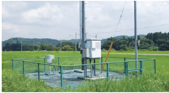
小鳩地区に設置されたアメダス
