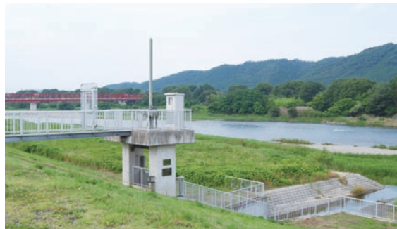
城東地区にある那珂川樋門
