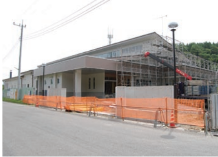
建設中の学校給食センター
