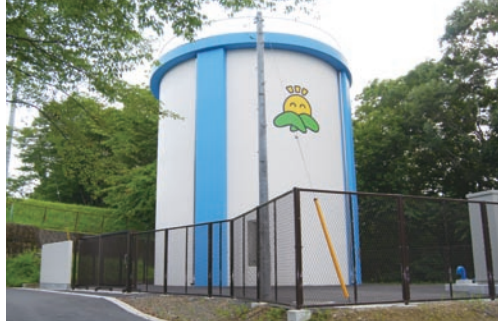
配水を開始する愛宕台配水タンク
