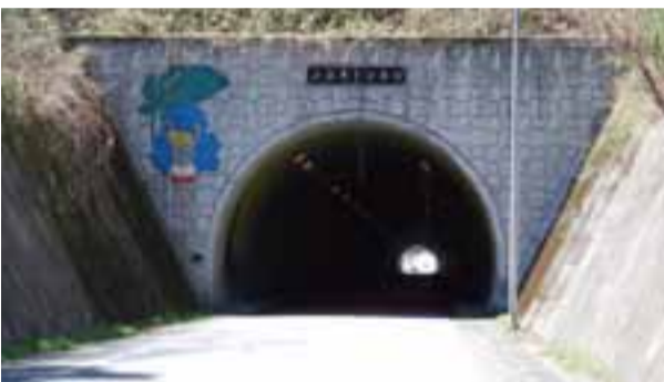
市の管理する小白井トンネル
