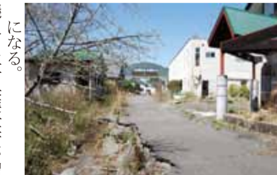
震災で壊滅的な被害を受けたこぶしの湯
