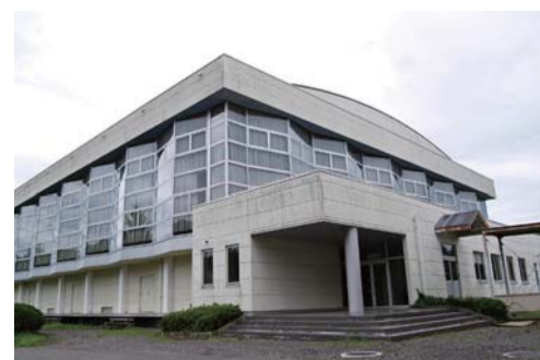
改修中の旧下江川中学校体育館
