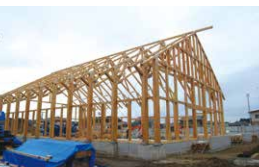
統合に向けて新たに建設中の武道館
