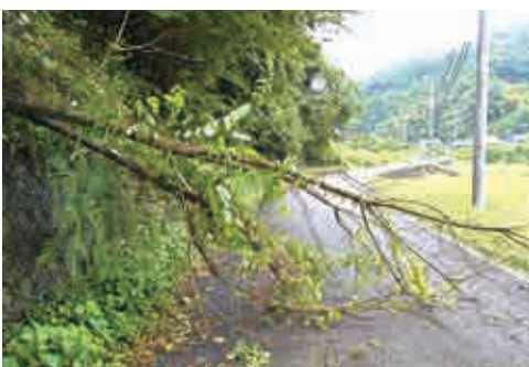
道路に覆いかぶさる倒木
