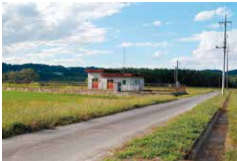
簡易水道施設 境浄水場
