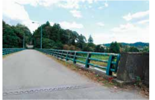
補修が計画されている藤田橋
