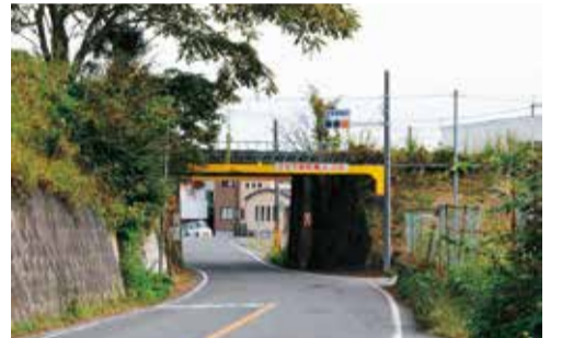
送電線設置が計画されている田野倉ガード周辺
