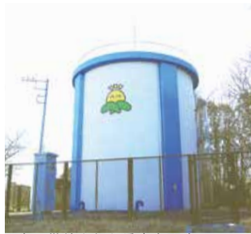
水の供給を行う愛宕台配水タンク
