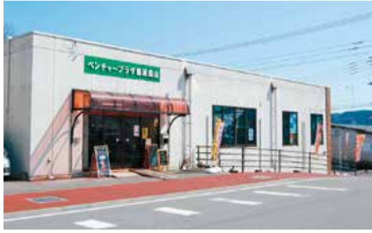
ベンチャープラザ那須烏山
