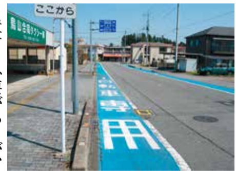
自転車通行帯を設置した県道
