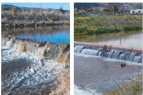
復旧した熊田地内の頭首工(左:復旧前、右:復旧後)
