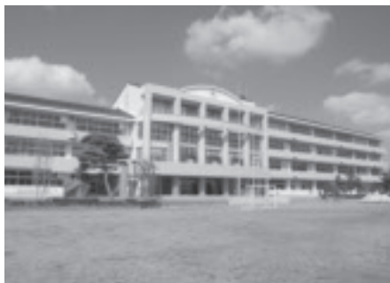
大規模改修された南那須中の校舎。
