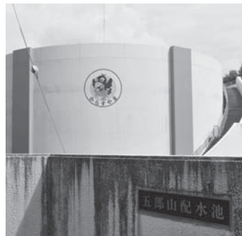
五郎山配水池
