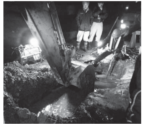
緊急で行なわれた漏水工事。
