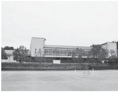
烏山中学校体育館耐震化対策事業。
