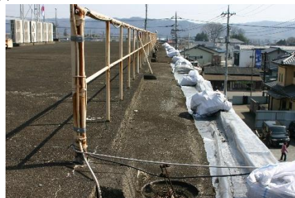
雨水の侵入を防ぐビニール（屋上）
