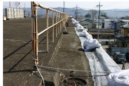
雨水の侵入を防ぐビニール（屋上）
