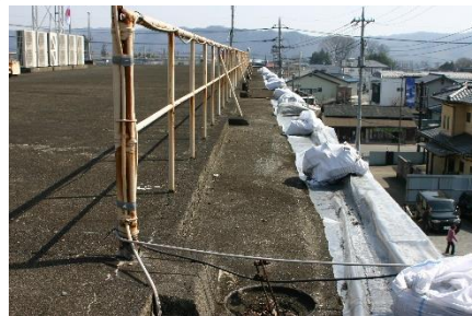
雨水の侵入を防ぐビニール（屋上）
