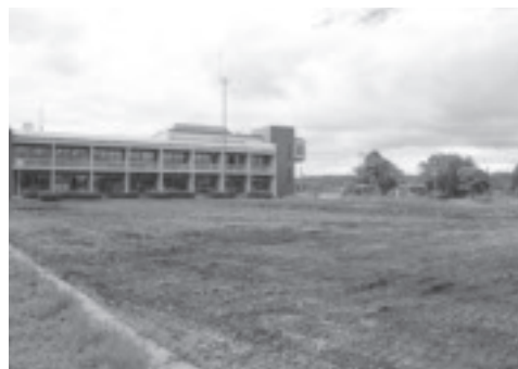
武道館の建設準備が進められる 市役所南那須庁舎隣公園跡。
