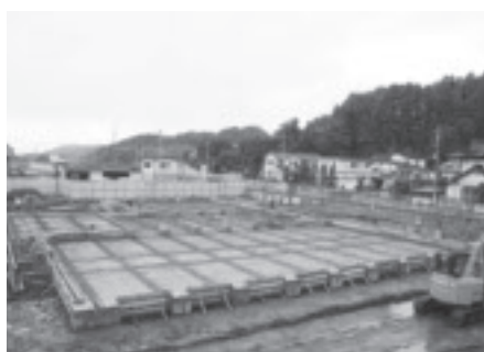
上：整備が進むJR烏山駅前広場。 下：新武道館建設の様子。
