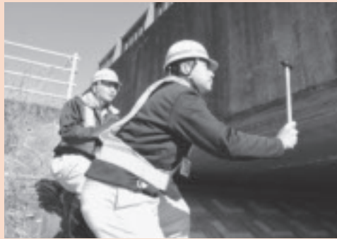
橋りょうを点検し、安全を確認
