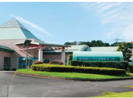
空調設備の整備を行う保健福祉センター
