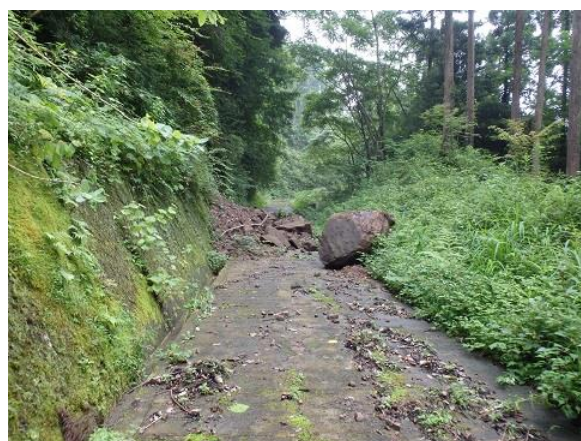
林道の損傷箇所 ▶
