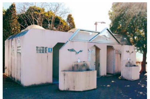
改修予定の緑地運動公園のトイレ
