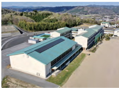
太陽光パネルが設置されている烏山小学校体育館
