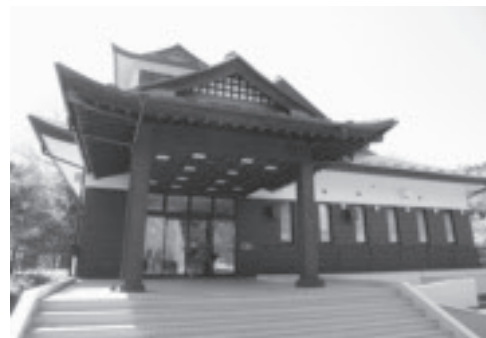
▲3月に改修工事を終え、4月にリニューアルオープンした龍門ふるさと民芸館
