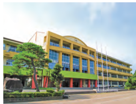
平成27年に統合した南那須中学校
