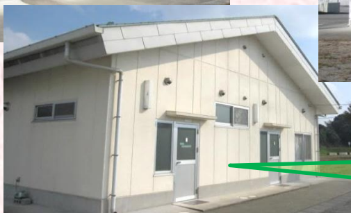
外側 トイレ入口
