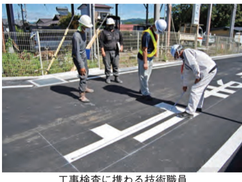
工事検査に携わる技術職員
