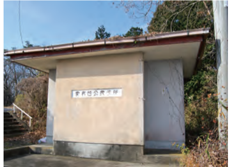
改修予定の愛宕台緑地公園のトイレ
