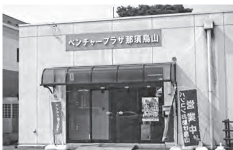
ベンチャープラザ那須烏山
