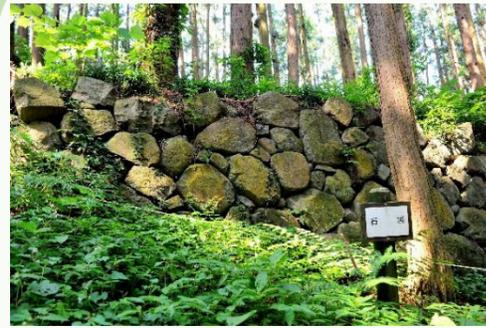
烏山城のシンボリックな石垣は常盤曲輪石垣(吹貫門脇石垣)です。この石垣は、地元産の自然石をあまり加工せずに積み石として用いられており、目地の隙間も広く、小詰石も少ないですが、石が動く余地のないように組み合っています。石垣の高さは、最も状態のいい部分で3メートルあり、扇のような反った勾配はなく直線的で、常盤曲輪の大手道に面し、吹貫門跡から約30メートルにわたり現存しています。
