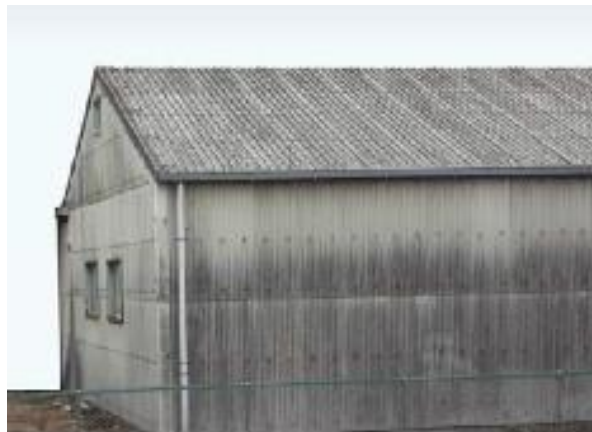
石綿含有スレート波板（屋根・外壁）
