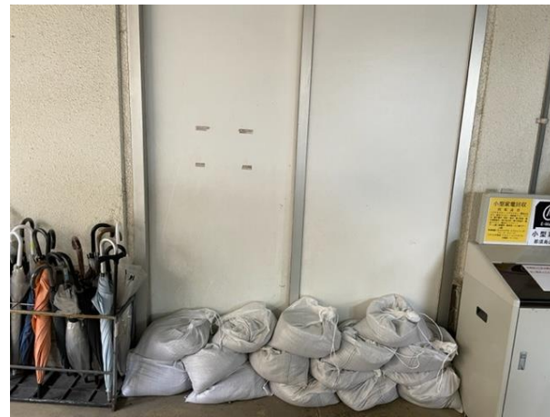
大雨時はサーバー室に通ずる扉周辺に土のうを設置
