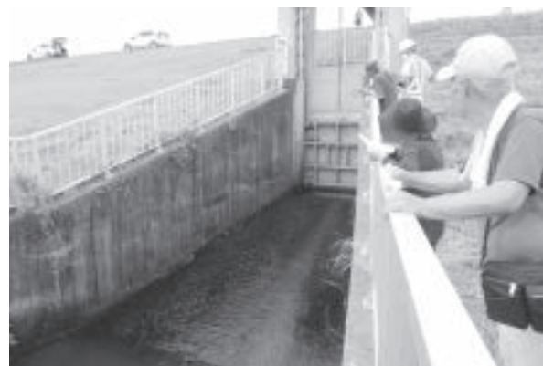
◀水門が閉じ、水が止まっているか確認する参加者
