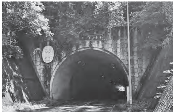
小白井トンネル
