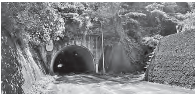
三箇・小白井トンネル
