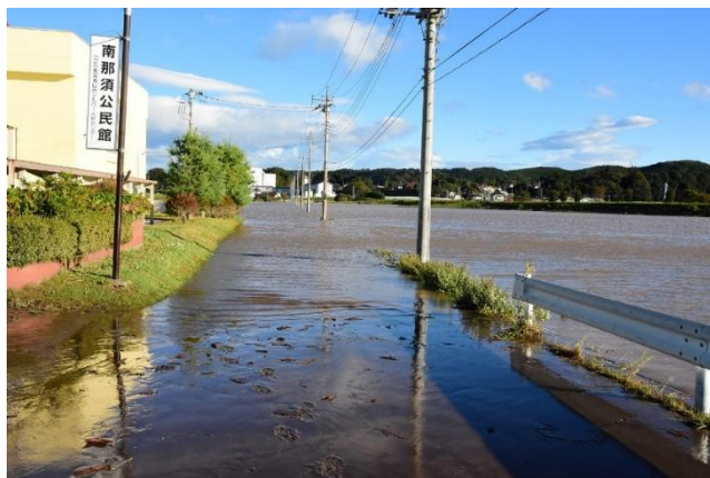
令和元年東日本台風による冠水被害 ▶
