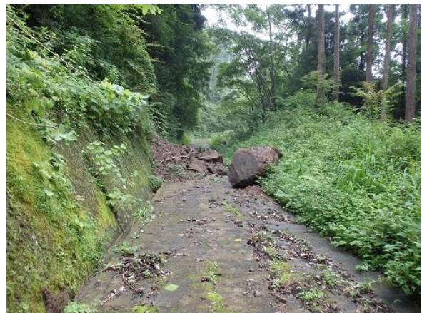
林道の損傷箇所 ▶
