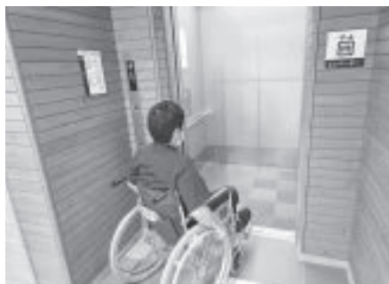
エレベーター設置によるバリアフリー対応（那珂川町役場庁舎）
