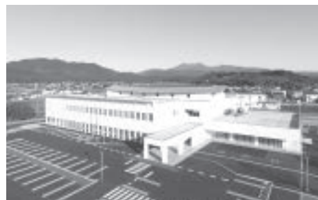
11月6日に開庁した 塩谷町役場新庁舎の外観
