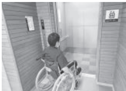
エレベーター設置による バリアフリー対応 (那珂川町役場庁舎)
