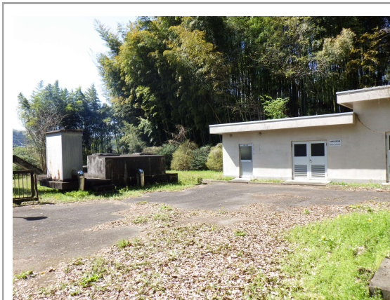
写一2. 16 興野水源地
