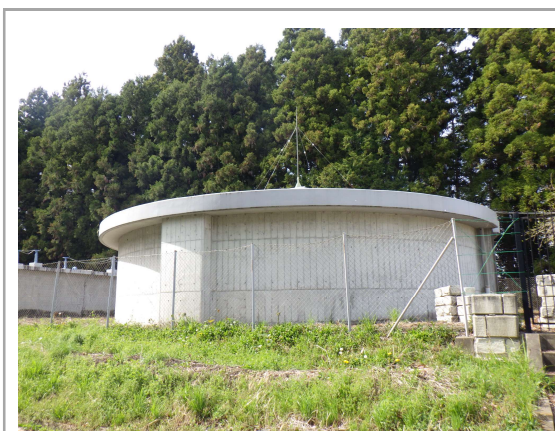
写一2.5 上川井配水場
