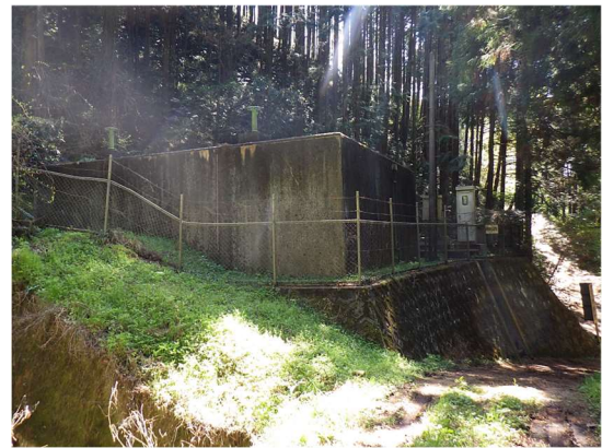
写一2. 17 興野配水池
