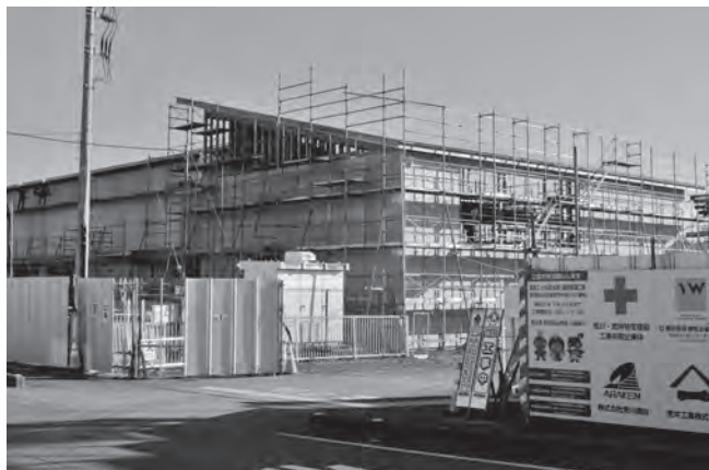
建設中のなすからこども園
