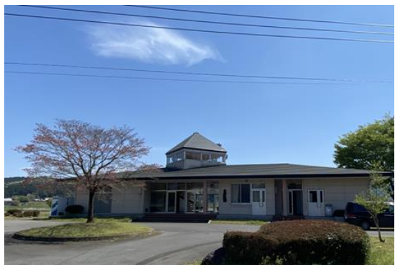
大桶運動公園管理棟
