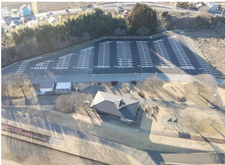
令和3年度から令和5年度にかけて整備した大桶運動公園駐車場
