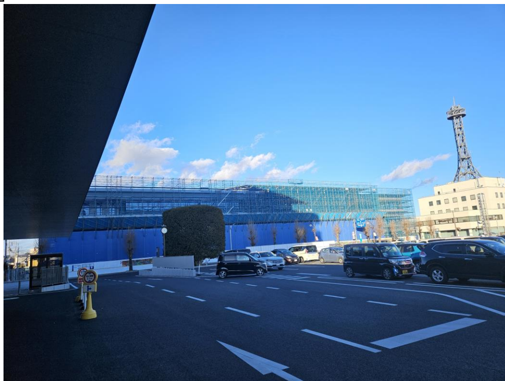
建設中の複合交流拠点
