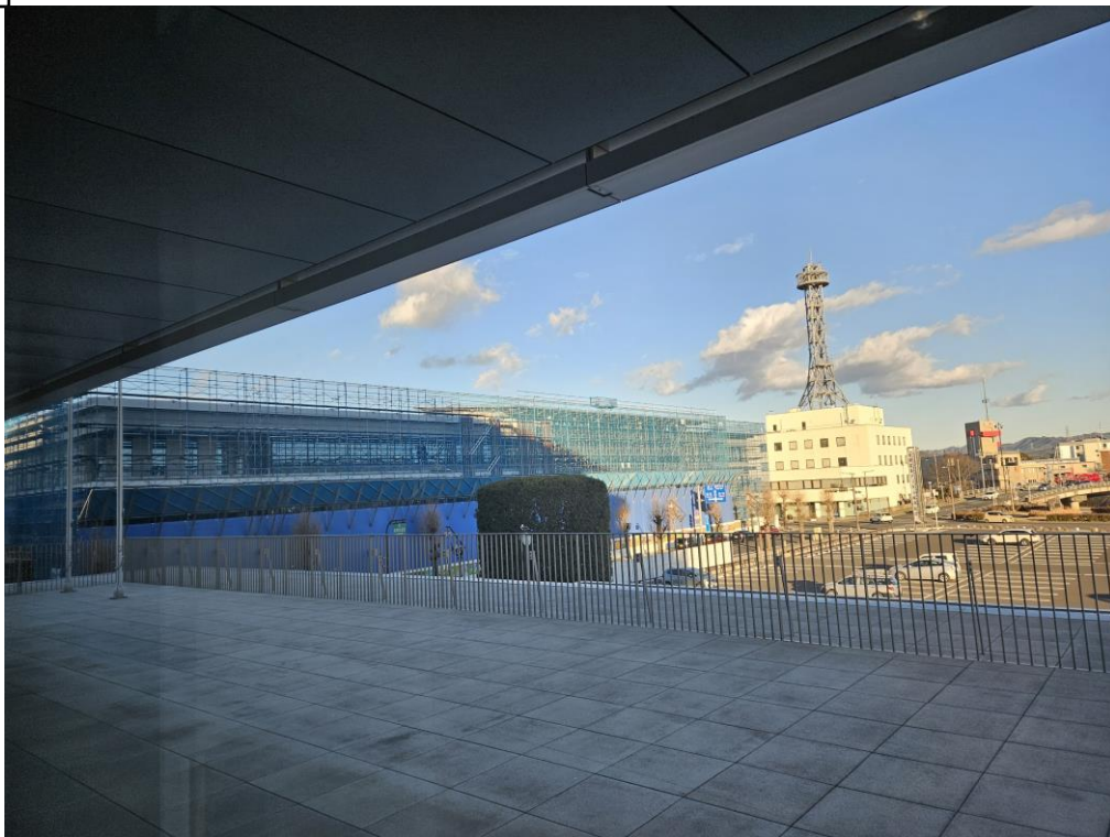
建設中の複合交流拠点
